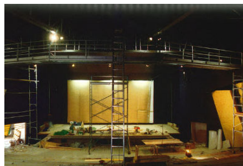
SALLE DE TRANSMISSION EN TRAVAUX, FUTUR AUDITORIUM.
