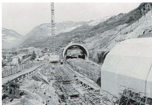
TUNNEL DE PONSERAND, CÔTÉ AIGUEBLANCHE, EN CONSTRUCTION.
